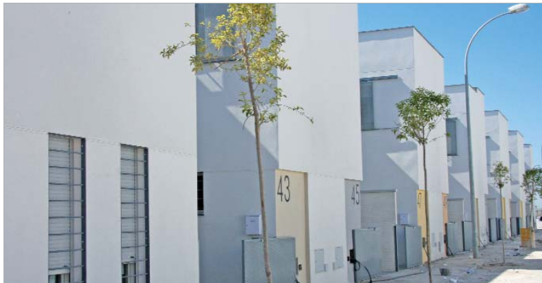
Las obras de la promoción de Secadero de Gutiérrez ya han finalizado.
