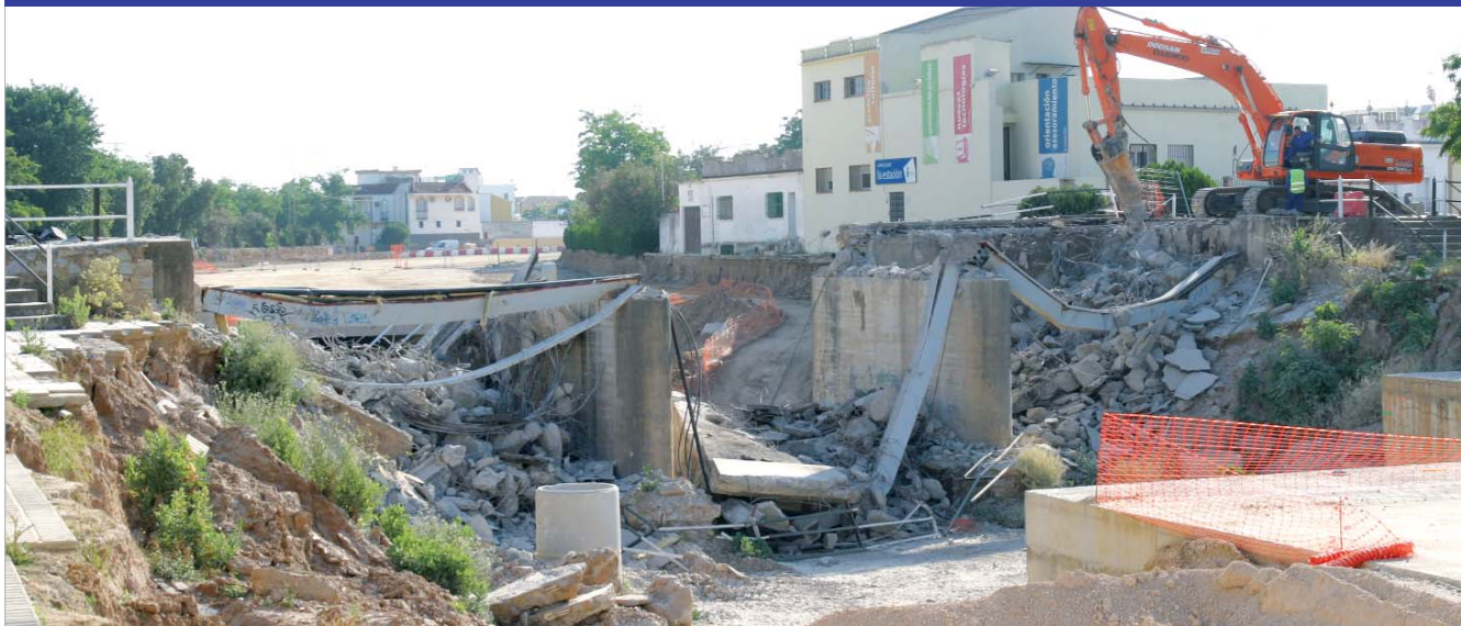
El puente de la calle San José ha sido ya demolido.
