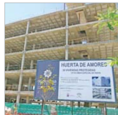
Huerta de Amores, en construcción.
