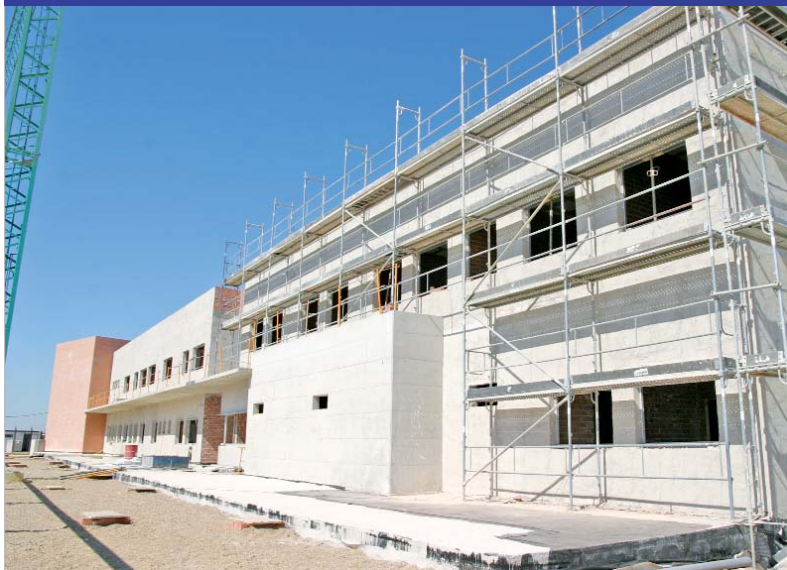
El edificio se encuentra casi al 50 por ciento de ejecución.
