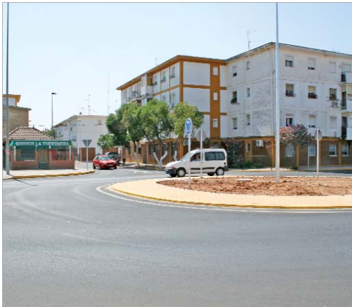
La rotonda de Haza de la Era ya está terminada.
