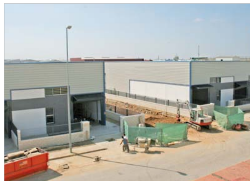
Las seis naves de El Cañamo 1, terminadas.
