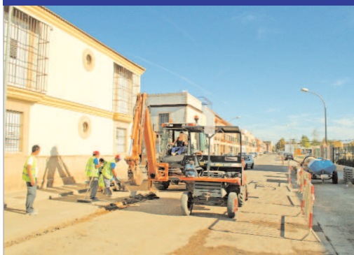
Las actuaciones en la vía Morse ya se han iniciado.
