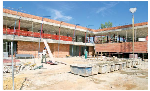
Las obras de la ampliación del Ayuntamiento se encuentran al 35 por ciento.
