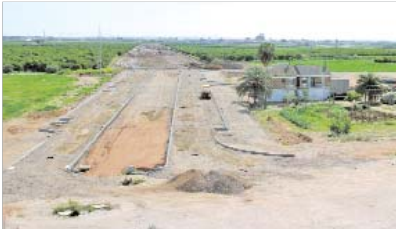
Estado actual de los terrenos donde se ubicarán las viviendas y que conectarán con la futura avenida de La Unión.
