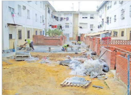
Uno de los patios de la Paz, durante las obras.
