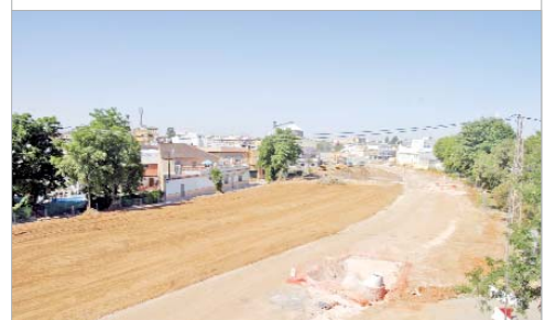
Las obras del segundo tramo, a pleno rendimiento.
