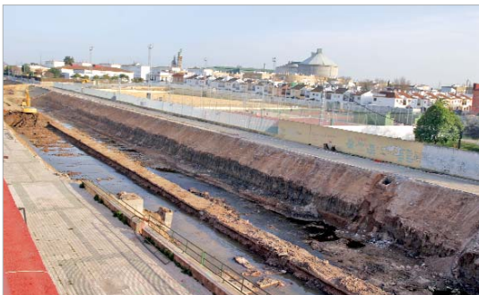
Imagen del arroyo antes de comenzar las obras de soterramiento.
