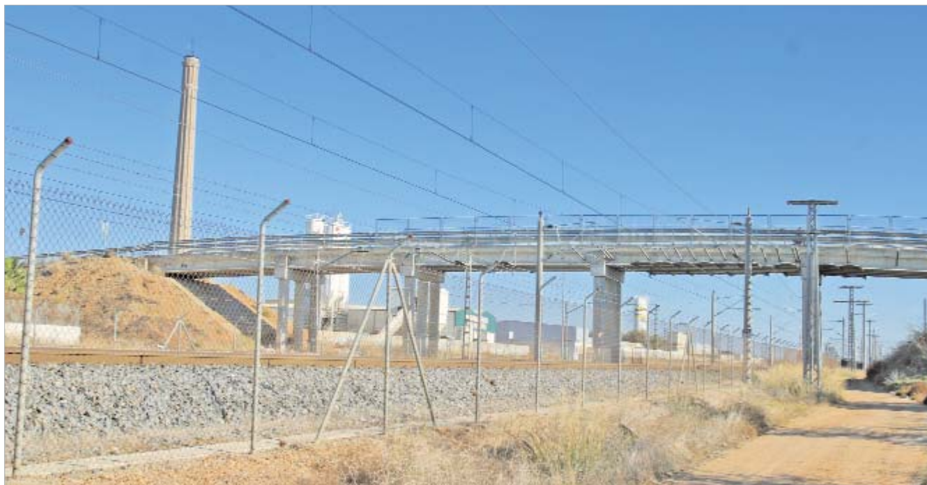
Vista general del tablero que comunica el núcleo urbano con las distintas fases del polígono el Cañamo.
