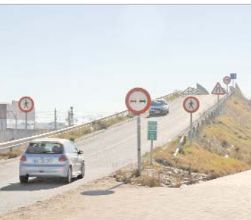
Se construirá una estructura paralela a la existente.
