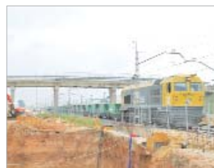
Vista general del puente.
