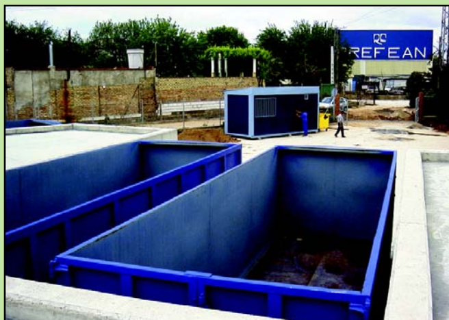
El punto verde de San José será ampliado para atender un mayor volumen de desechos no autorizados en contenedores normalizados.
