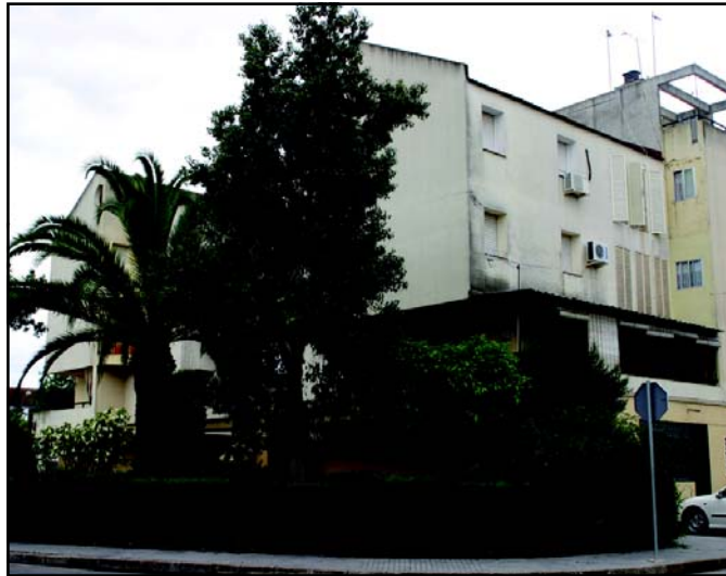
La primera fase para la transformación de La Estacada contempla la remodelación de la infraestructura de abastecimiento de agua de la barriada y las calles Limón, Naranjo, Nogal, Virgen de Guadalupe y María Auxiliadora.
