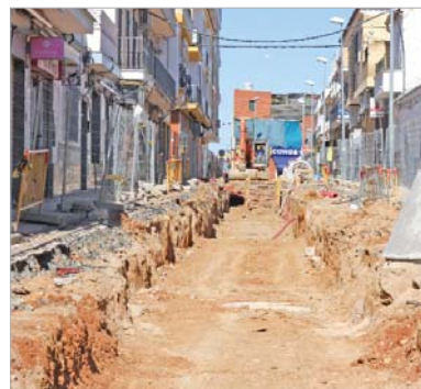
Imagen de las obras en la calle Málaga.
