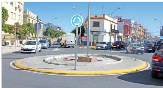
Las actuaciones en Carretera Bética ya han concluido.
