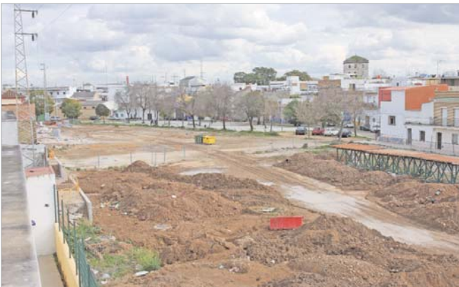
Situación actual del tramo intermedio del Paseo del Almonazar.
