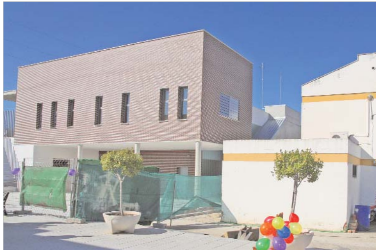
Imagen del Centro Ocupacional actual y del nuevo, en construcción en estos momentos.
