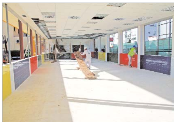
El comedor conecta con la cocina a través de una doble puerta.
