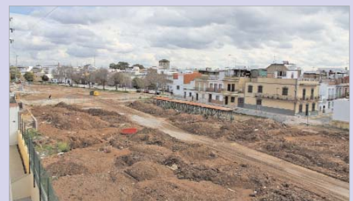
Comienzan las obras de embellecimiento del último tramo.
