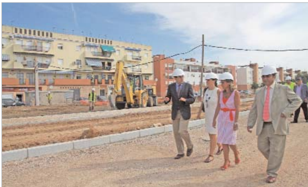
La consejera de Medio Ambiente, Cinta Castillo, visitó las obras.
