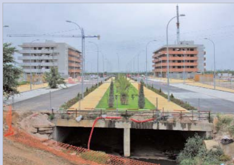
La zona una vez que comienzan las obras.
