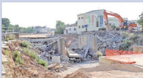
Las máquinas derriban una estructura emblemática en la localidad.
