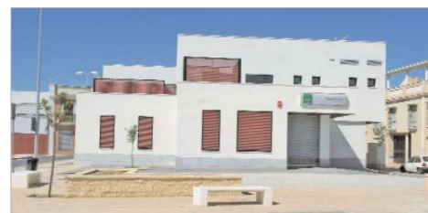
El nuevo centro de salud de La Rinconada.
