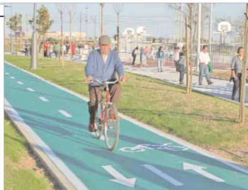
Carril bici del segundo tramo del Paseo del Almonazar.
