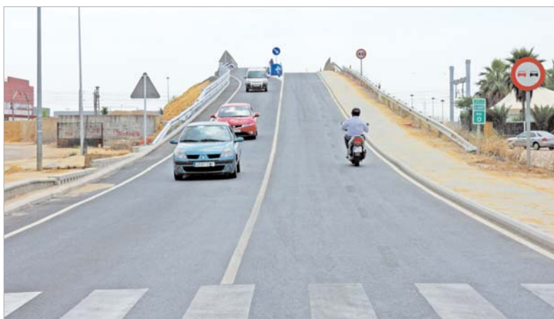
La ampliación del puente del Cañamo es ya una realidad.
