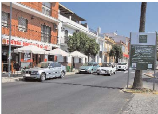
La calle carretera Bética ha sido una de las vías arregladas.
