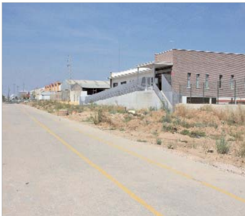
Las obras del segundo tramo del Paseo Almonazar empiezan en septiembre.
