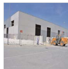
Las seis naves en construcción.
