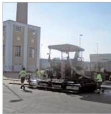
Obras en el Cádizamo 1.
