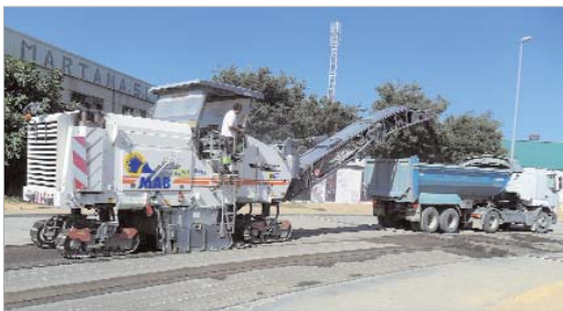
Ya han comenzado las obras para renovar el asfalto del Cábano 1.
