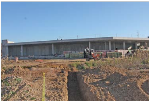
Imagen de las obras en la antigua gravera de Los Labrados.
