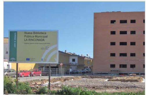
Las obras siguen el ritmo previsto y estarán listas en unos 12 meses.
