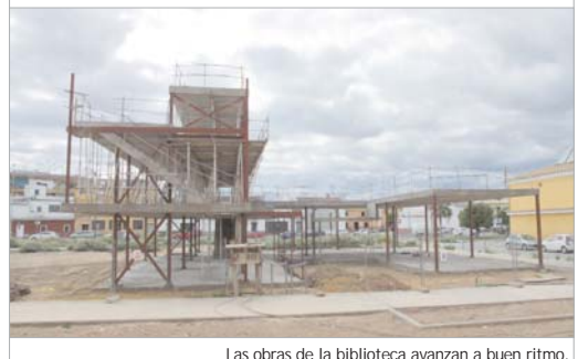
Las obras de la biblioteca avanzan a buen ritmo.
