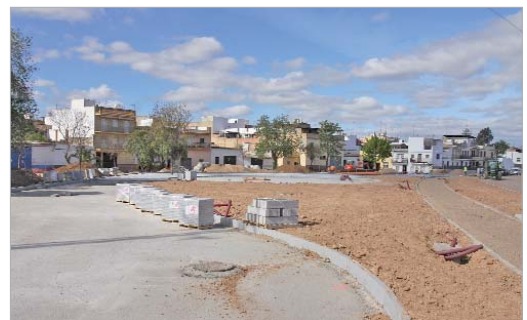
Las obras del segundo tramo se encuentran muy avanzadas.
