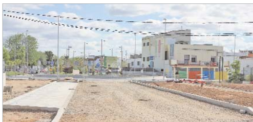
Obras del Almonazar
