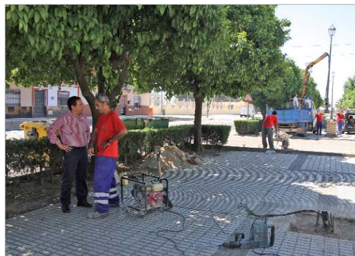
Romero Campos en una visita reciente a las obras de renovación.
