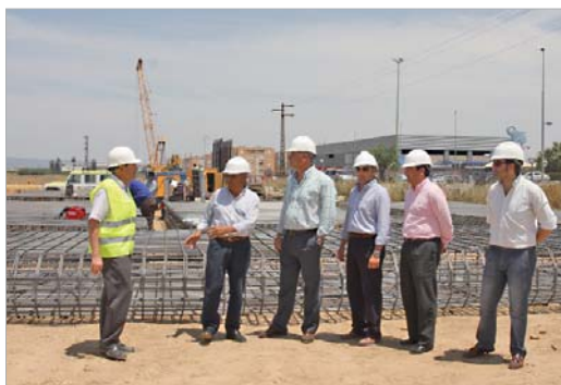
Los ediles de Urbanismo y Vía Pública en una visita a las obras.
