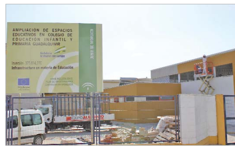
Las obras en el colegio Guadalquivir avanzan a buen ritmo.
