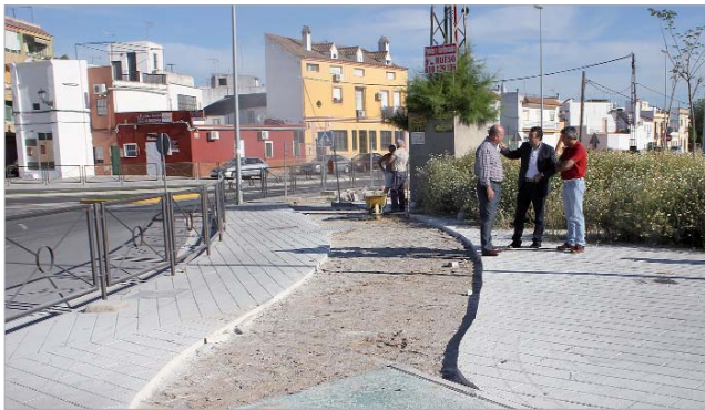
El alcalde, Javier Fernández, comprobó de primera mano la ampliación del Carril Bici.
