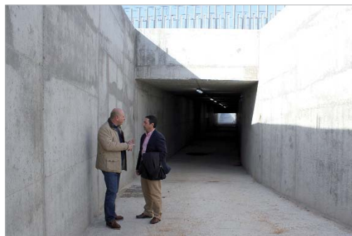
Los edificios de Urbanismo y Vía Pública junto a la inca o paso subterráneo.
