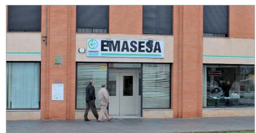
Edificio de Emasesa en La Rinconada.
