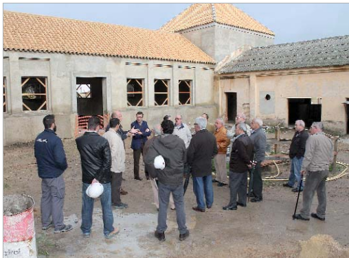
El Centro de Interpretación del Agua se ubica en las alas norte y este de la Hacienda.
