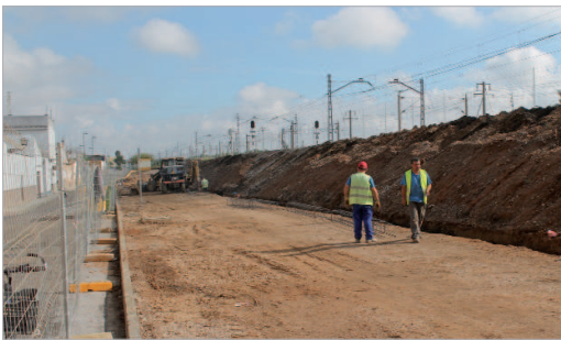
Vista de las actuaciones en calle Murcia
