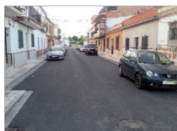
La calle San Fernando, tras la obra.
