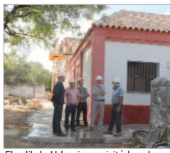
El edil de Urbanismo visitó las obras.
