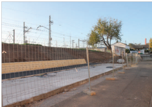
Estado de las obras en el entorno.
