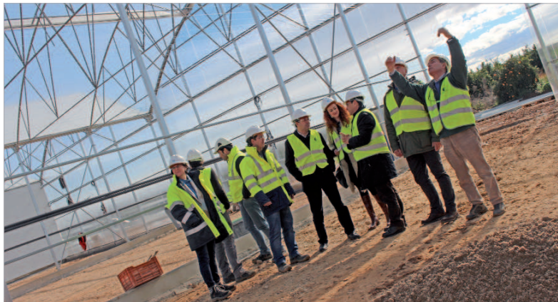
El alcalde, Javier Fernández, realizó una visita a las obras.
