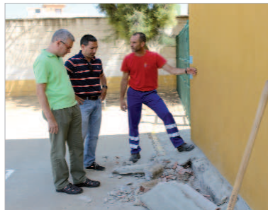
Obras del CEIP Guadalquivir.
