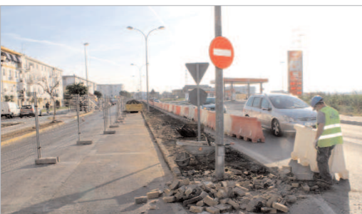
La calle Juan de Austria en plena ejecución de las obras.
