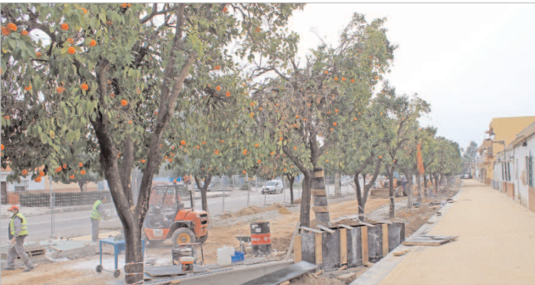
La segunda fase de las obras para la modernización de la avenida 28 de Febrero, en pleno funcionamiento.
