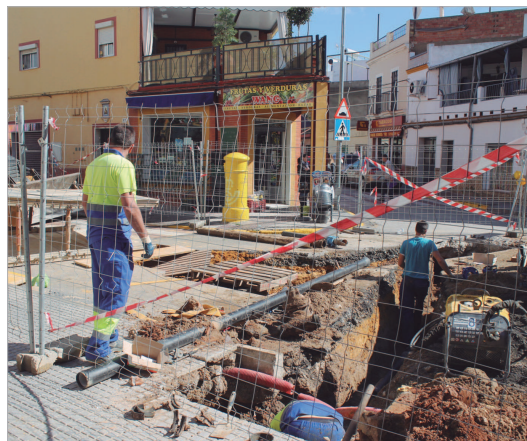
Imagen de las obras en la calle Juan de la Cueva.
