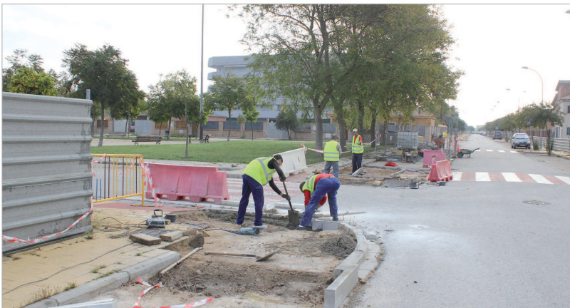
Las obras para la ampliación del carril bici de La Rinconada.
