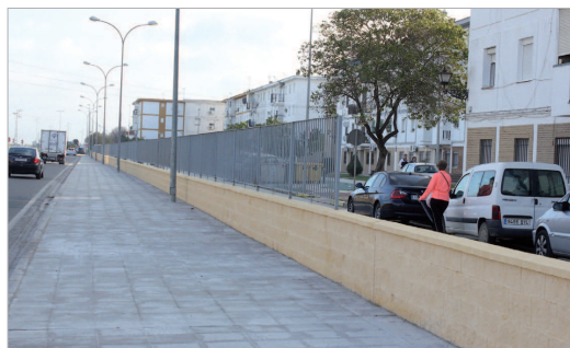
Las obras de la calle Juan de Austria ya han finalizado.
