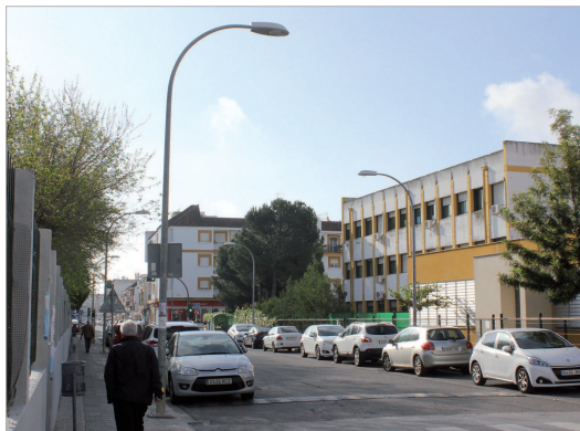
Nueva luminaria en la calle Madrid.
