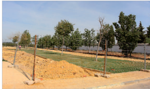
Las obras en el parque del cementerio de Rinconada ya han empezado.
