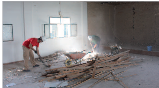
Las obras en el interior del edificio ya han comenzado.
