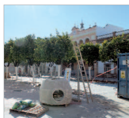
Obras casco histórico Rinconada.
