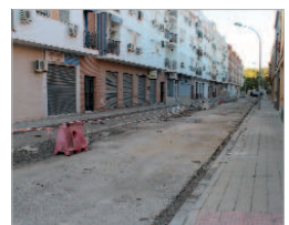
Obras en María Vázquez Ponce.
