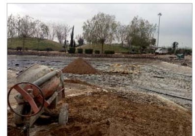
Se ha hormigonado el fondo para facilitar la tarea.
