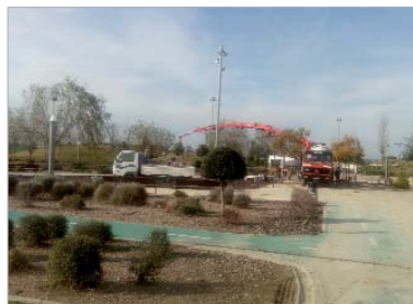
Proceso de vaciado de la lámina de agua.
