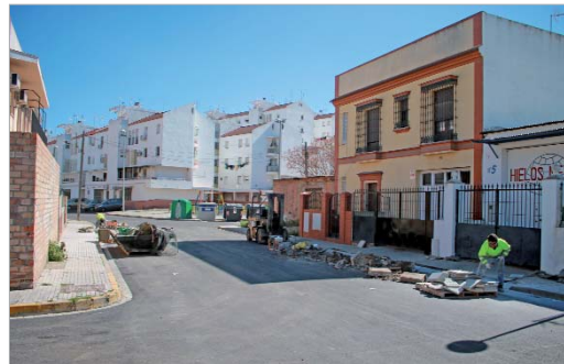
Seis calles de La Rinconada remodelan su pavimento.
