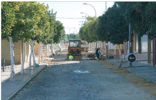
Calle Cristo del Perdón en remodelación.
