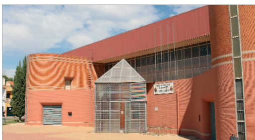
El pabellón deportivo Fernando Martín verá remodelada su cubierta.
