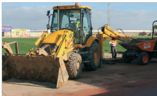
Las obras en el estadio Felipe del Valle ya han comenzado.
