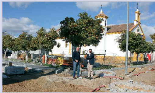
Díez y Romero Campos visitaron recientemente las obras.
