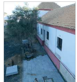
Obras del acero perimetral.
