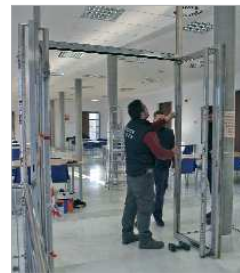
Obras de insonorización.
