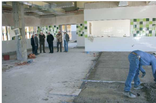
Visita a las obras del alcalde Javier Fernández.
