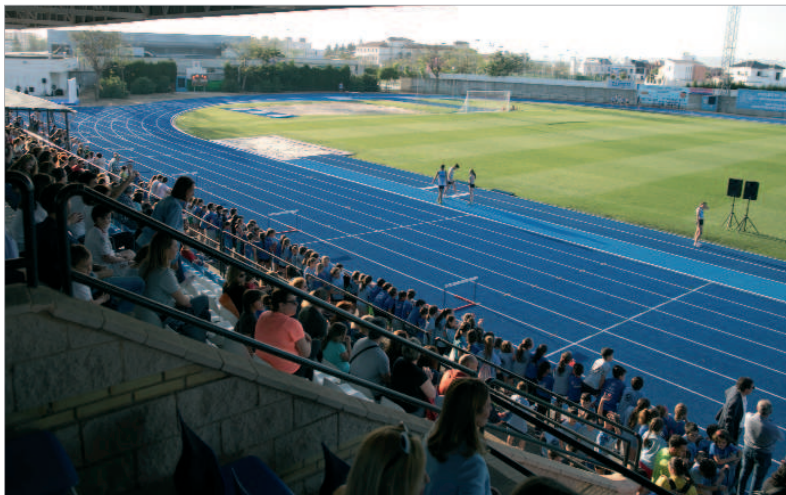
El nuevo pavimento de la pista del Felipe del Valle, en una instantánea tomada desde las gradas del estadio.
