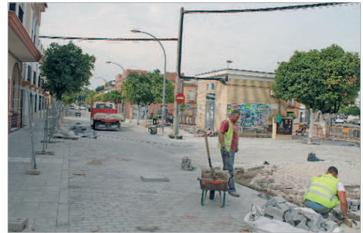
A final de mes terminan las obras en la calle.
