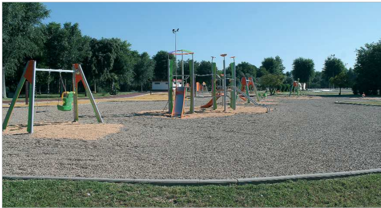
Las obras ha mejorado los espacios del parque para un mayor disfrute ciudadano.
