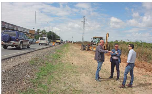
Díez y Romero Campos visitan la zona a reformar.
