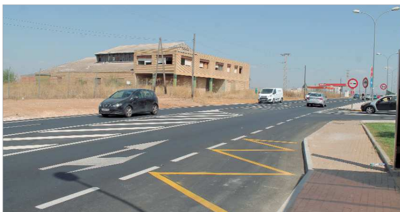
El tercer carril permite un tráfico más fluido en esa zona del municipio.
