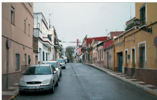
La calle Santa Cruz verá renovado su saneamiento y abastecimiento.
