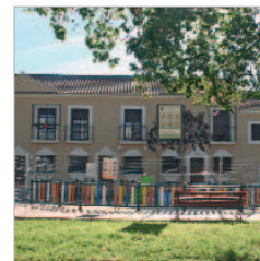
La Plaza Aragón, en obras.
