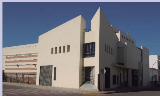
Obras de reforma en el Centro Cultural Antonio Gala.
