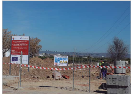
Las obras ya han comenzado.
