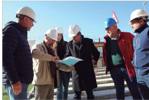
Fernández, Bueno y Díez revisan el estado de las obras.
