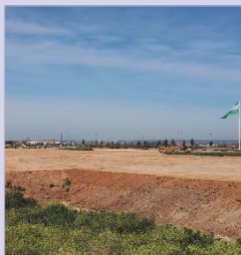
Vista de las obras del 'Abrazo'.
