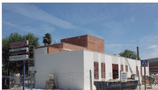
El CRAES contará con una nueva sede cuyas obras están muy avanzadas.
