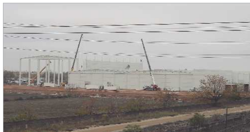
Herba construye el Centro Agroalimentario del Arroz en La Rinconada.
