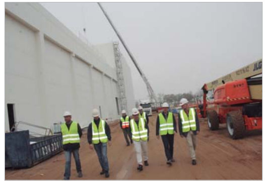
Los delegados Díez y Romero Campos, durante la visita a las obras.
