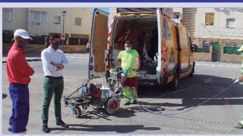
El delegado de Infraestructuras Públicas, Rafael Reyes, en las obras.
