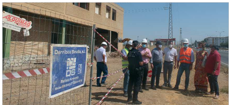
Imagen de la demolición de la antigua panificadora San José.
