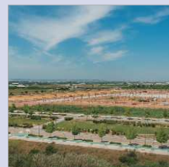
Construcción de 'El Abrazo'.
