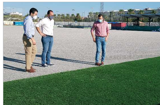
El alcalde, Javier Fernández, durante una visita a las obras de sustitución.
