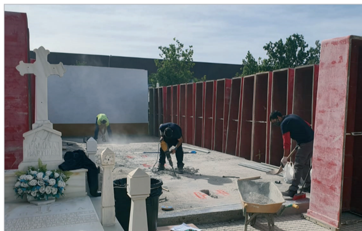
Imagen de las obras de ampliación del cementerio de La Rinconada.
