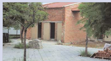
En Carretera Bética se construye la 'Casa del Flamenco'.
