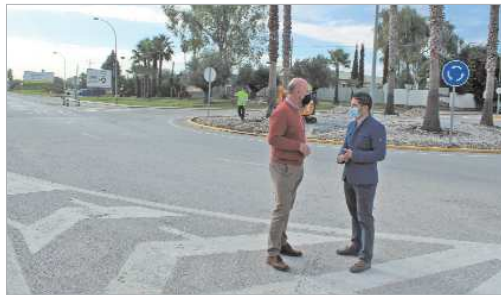
Rafael Reyes y Francisco Manuel Díez visitaron las obras.
